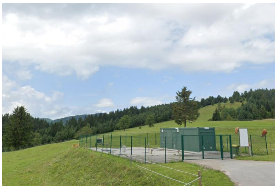
Slika 15: Čistilna naprava Mali Log
