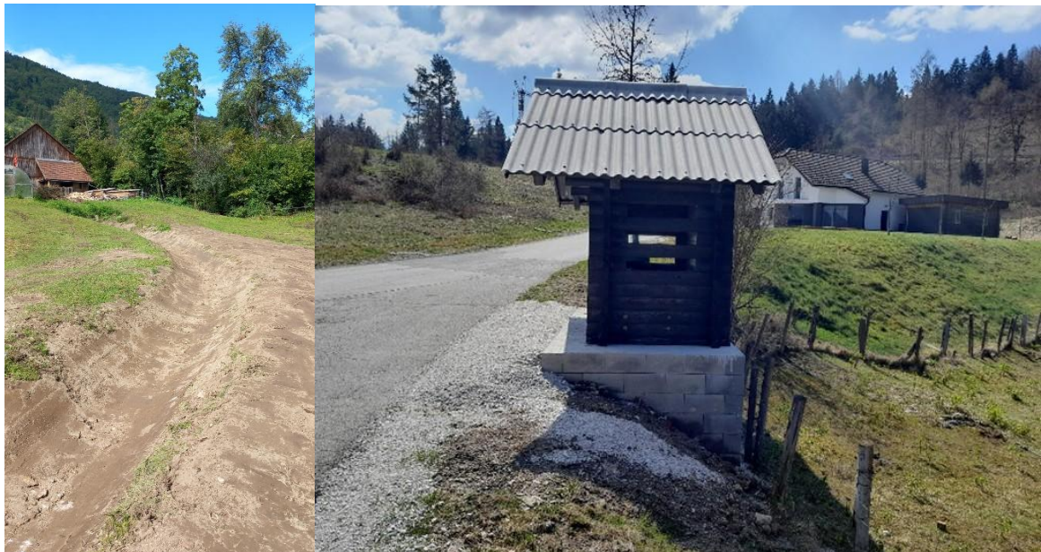
Slika 28: Ureditev meteornega kanala v Danah. Slika 29: Ureditev avtobusne postaje (Grčarice).
