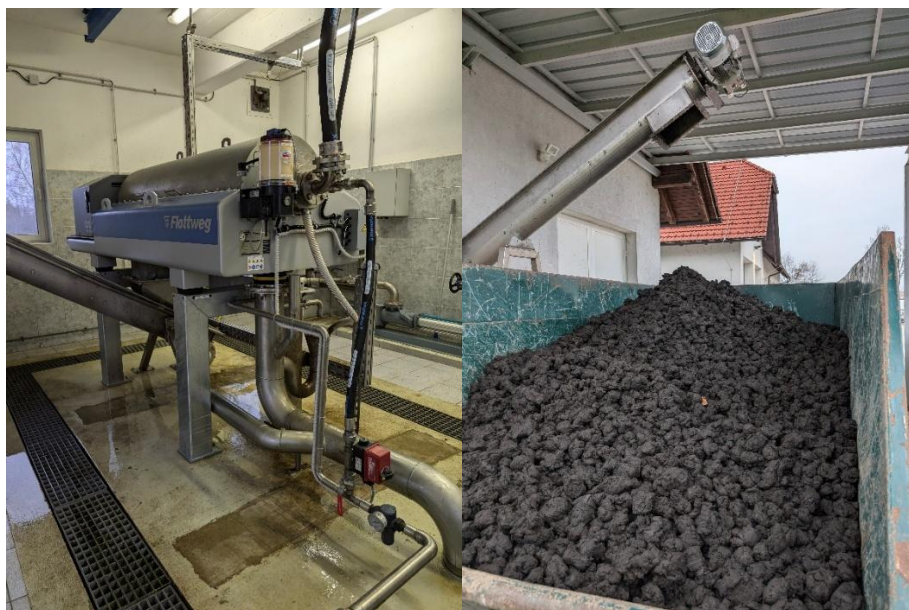
Slika 14: Za potrebe ločevanja blata in vode se uporablja dehidracijski stroj, ki deluje po principu centrifuge. V tem procesu se loči voda od blata in se dobi suh, kompakten odpadek – suho blato.
