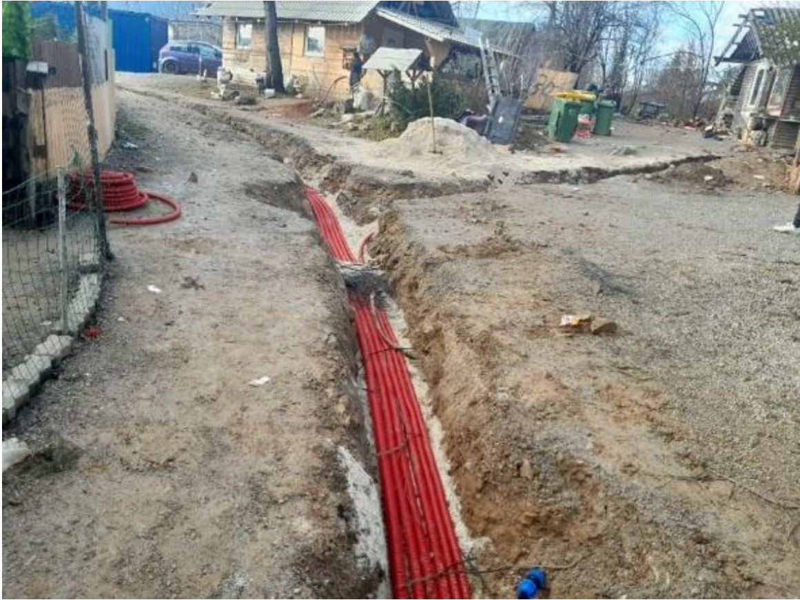
Slika 27: Izgradnja elektro omrežja v romskem naselju Lepovče
